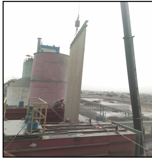
技改过程照片 2
