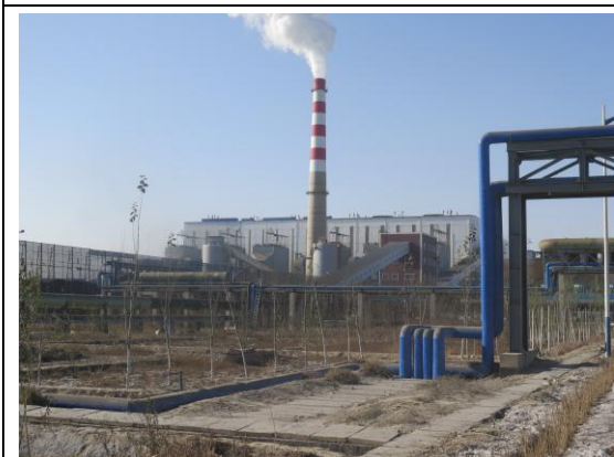
现有锅炉废气排气筒 95m
