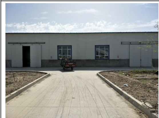
危险废物储存场所 (废活性炭、废机油)
