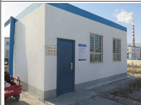
污水处理设施总排口在线监测设备用房
