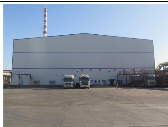
一期现有酸、碱原料库区
