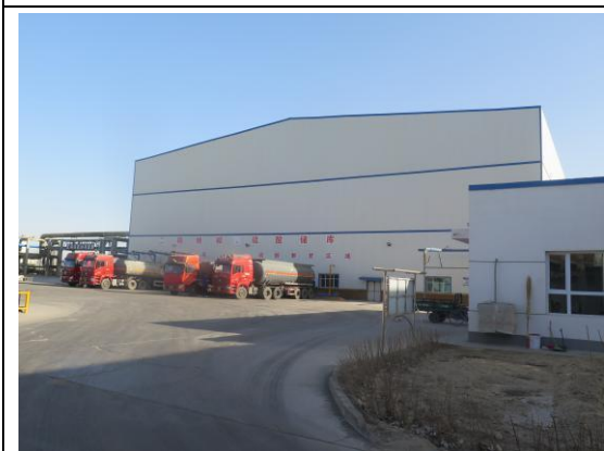
现有二期酸、碱原料库区
