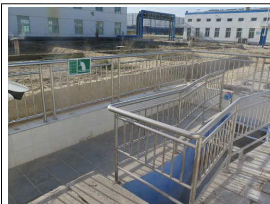
全厂废水总排口标示牌
